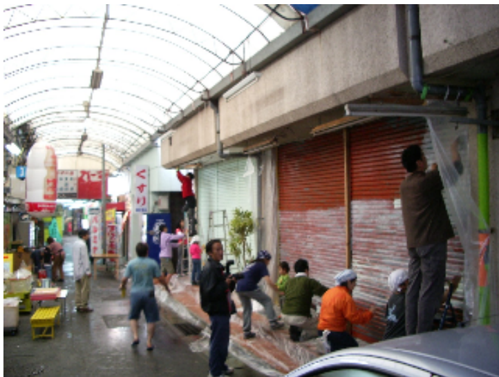
天気はあいにくの大雨！養生が大変でした。 近所の玉寄勢電気さんがずいぶん助けてくれました
